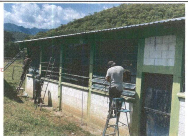
Foto 4: en proceso de instalación de balcones.
