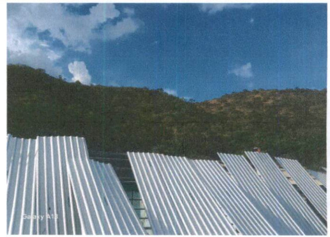
Foto 2: En proceso de instalación de láminas
